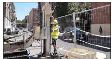
Fig. 6, Iniezioni direct push sulla strada in Area 4
