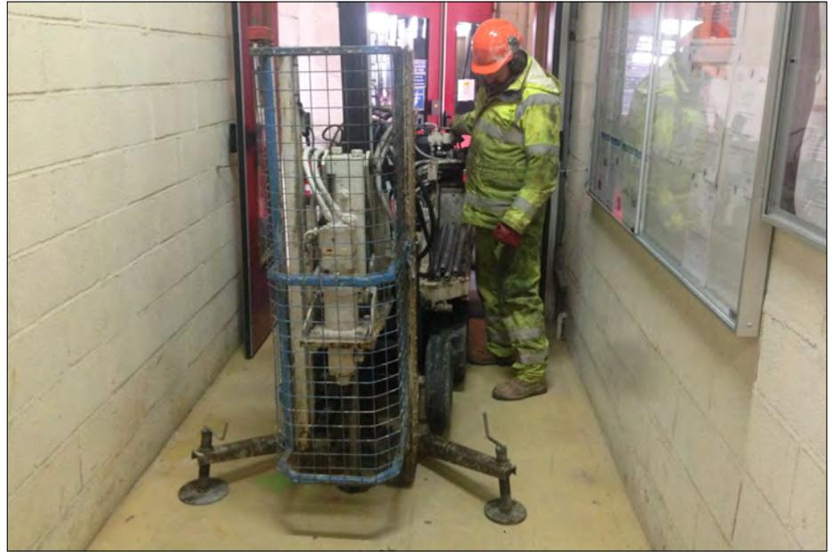
Fig. 4 Traitement barrière par injection dans le panache en aval, depuis l'intérieur du bâtiment de l'usine
