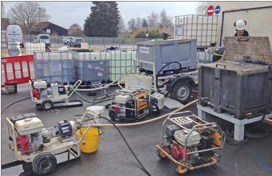
Fig. 1 Aire de mélange du 3DMe sur le site
