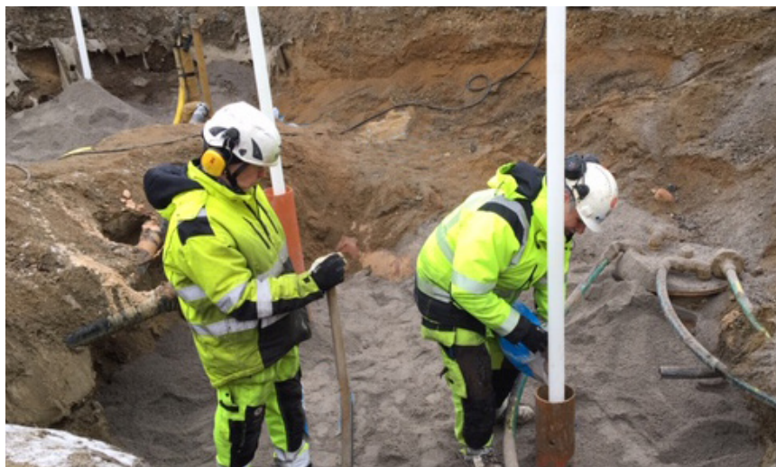
Fig. 1 (en haut). Excavation ciblée autour des réservoirs souterrains Fig. 2 (en bas). Installation des puits d'injection par RGS Nordic
