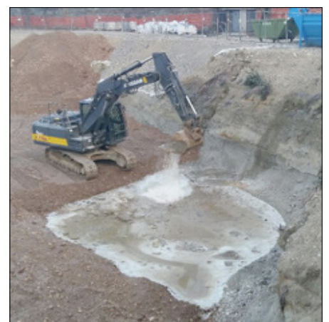
Fase II Aplicación de pellets de ORC Advanced
