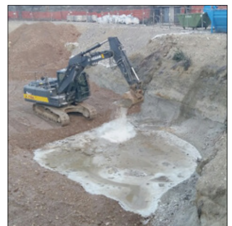
Fase II Aplicación de pellets de ORC Advanced
