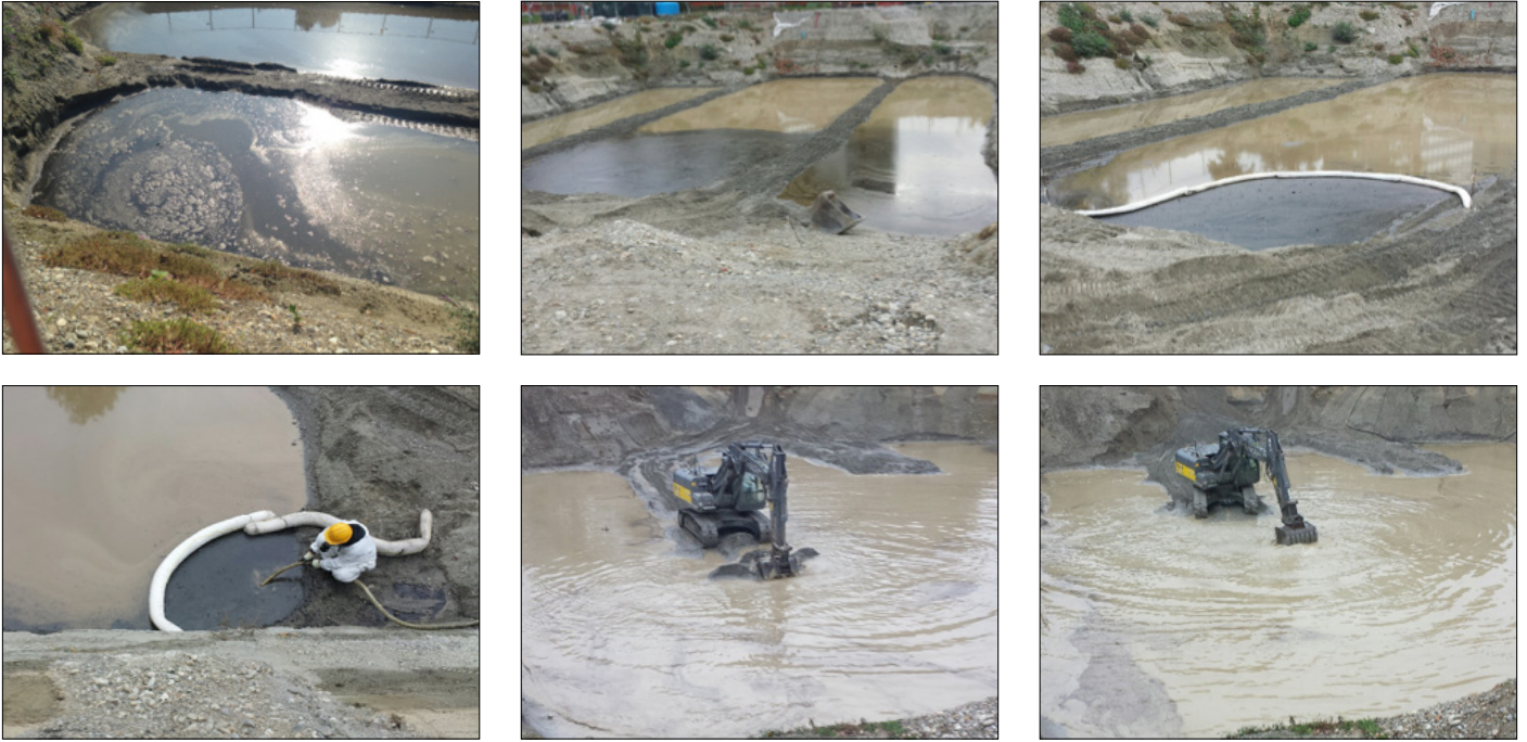
Aplicación Fase I: Desorción y extracción mejoradas con PetroCleanze
