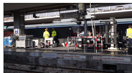
Fig. 6 : injection de PlumeStop depuis le quai de la gare ferroviaire, en zone 3.
