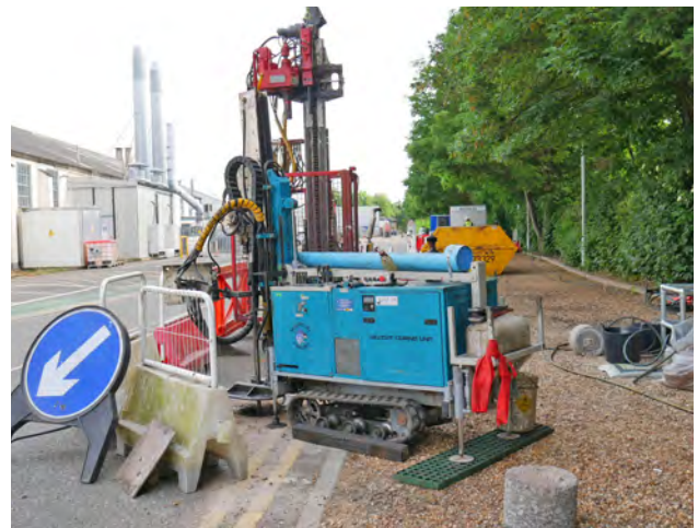
Fig. 11 Rigs on site
