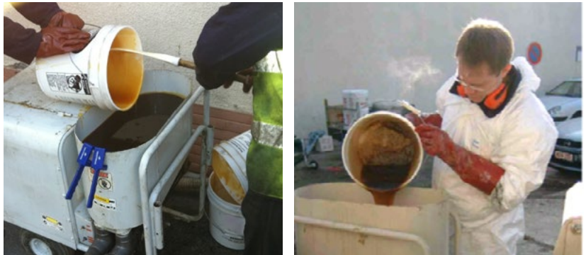
Fig. 3 e 4: Pompa a pistone con tramoggia incorporata
