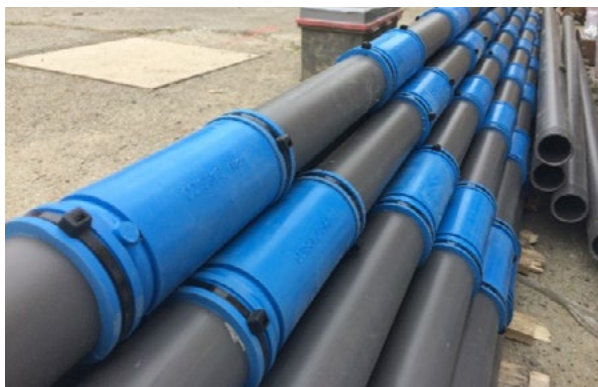
Fig.5: Tuberías para puntos fijos con válvulas (izquierda) y obturadores inflables dobles para inyección en puntos fijos con válvulas (derecha)
