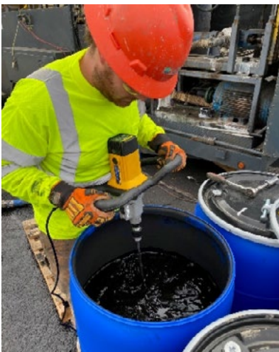
Homogénéisation de PetroFix avec un malaxeur portatif
