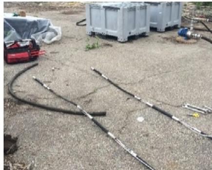
Fig. 7: Tubazioni per postazione fissa valvolata (sinistra) e doppi packer per iniezione in postazione fissa valvolata (destra)
