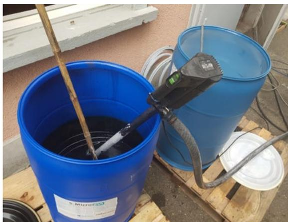
Fig. 1 Fusto con S-MicroZVI concentrato e pompa tirafusti.
